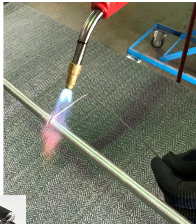
ろう付の施工中
